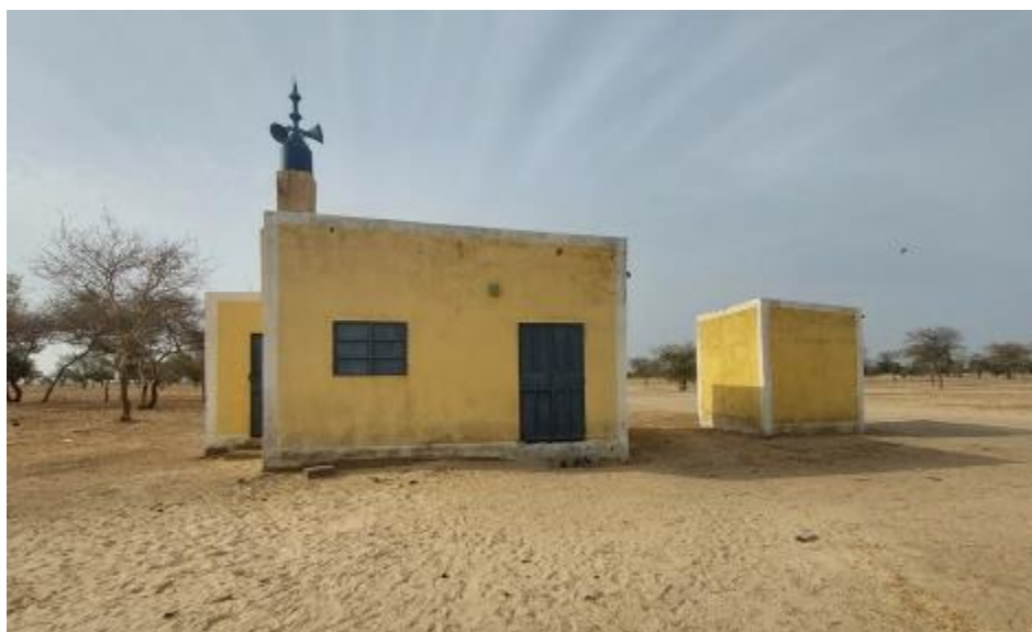
Figure 72 : Mosquée sur le site de la centrale
