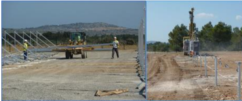
Figure 16 : Assemblage des structures métalliques et de la mise en place du système d'ancrage des structures porteuses
