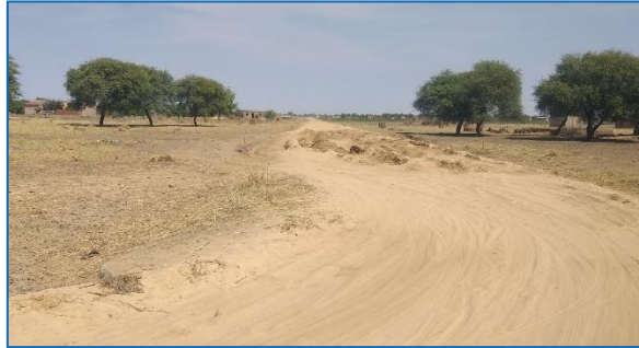
Figure 31: Nature limoneuse de certains tronçons de la piste d'accès
