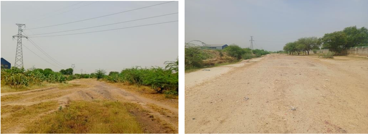
Figure 66 : Vue générale de la route d'accès (route de 20) et de la ligne de raccordement de Lamadji
