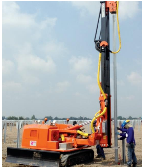
Figure 9 : Système des pieux battus
