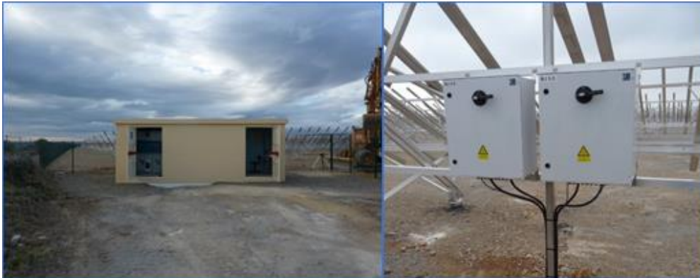
Figure 17: Installation du poste de livraison (entrée principale de la centrale) et des boîtes de jonction et raccordement jusqu'aux onduleurs
