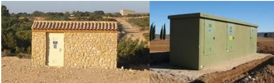
Figure 11 : Exemple de locaux techniques
