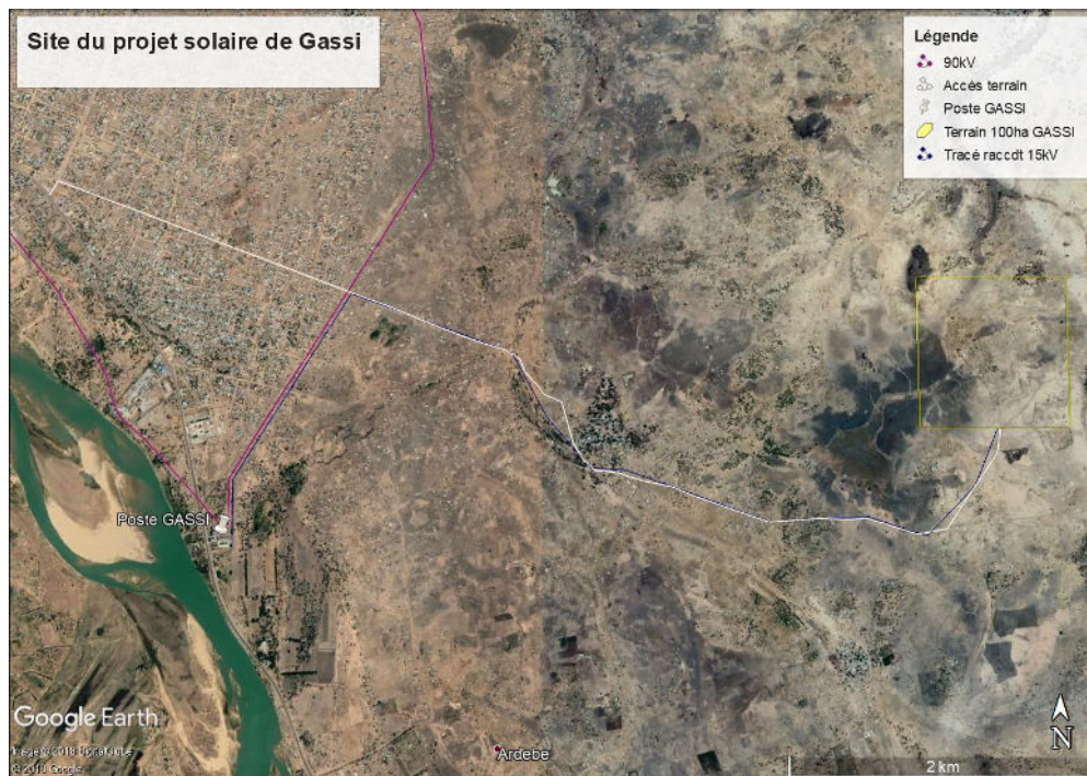
Figure b : Centrale Gassi et son raccordement
